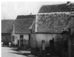
Links: Häuser aus luftgetrockneten Lehmziegel; rechts: Sandstein-Fundament
