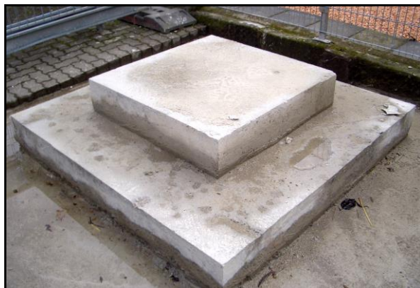
Das neue Betonfundament (Foto: N. Kästel).
