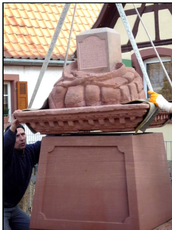
Der alte Abdeckstein wird auf den neuen Sockelblock gesetzt (Foto: Martin Kästel).
