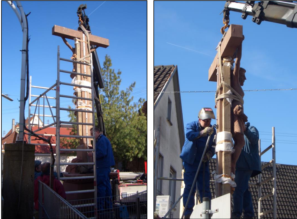
Arbeiter beim Aufbau des restaurierten Kreuzes (Foto: N. Kästel).
