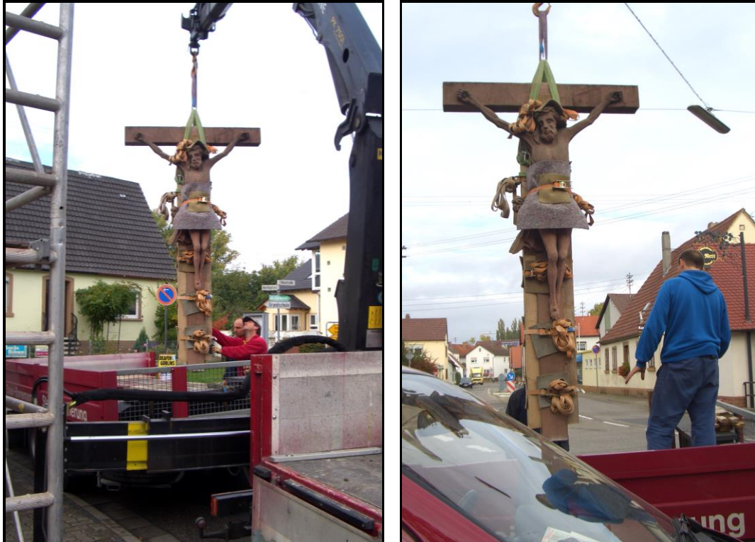
Das Kreuz wird abgebaut (Foto: N. Kästel)..
