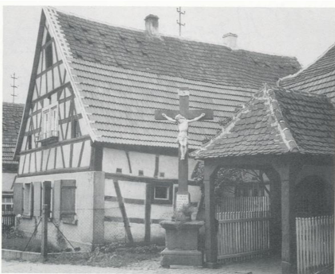
Bildhäusel vor der Renovierung (um 1960)
